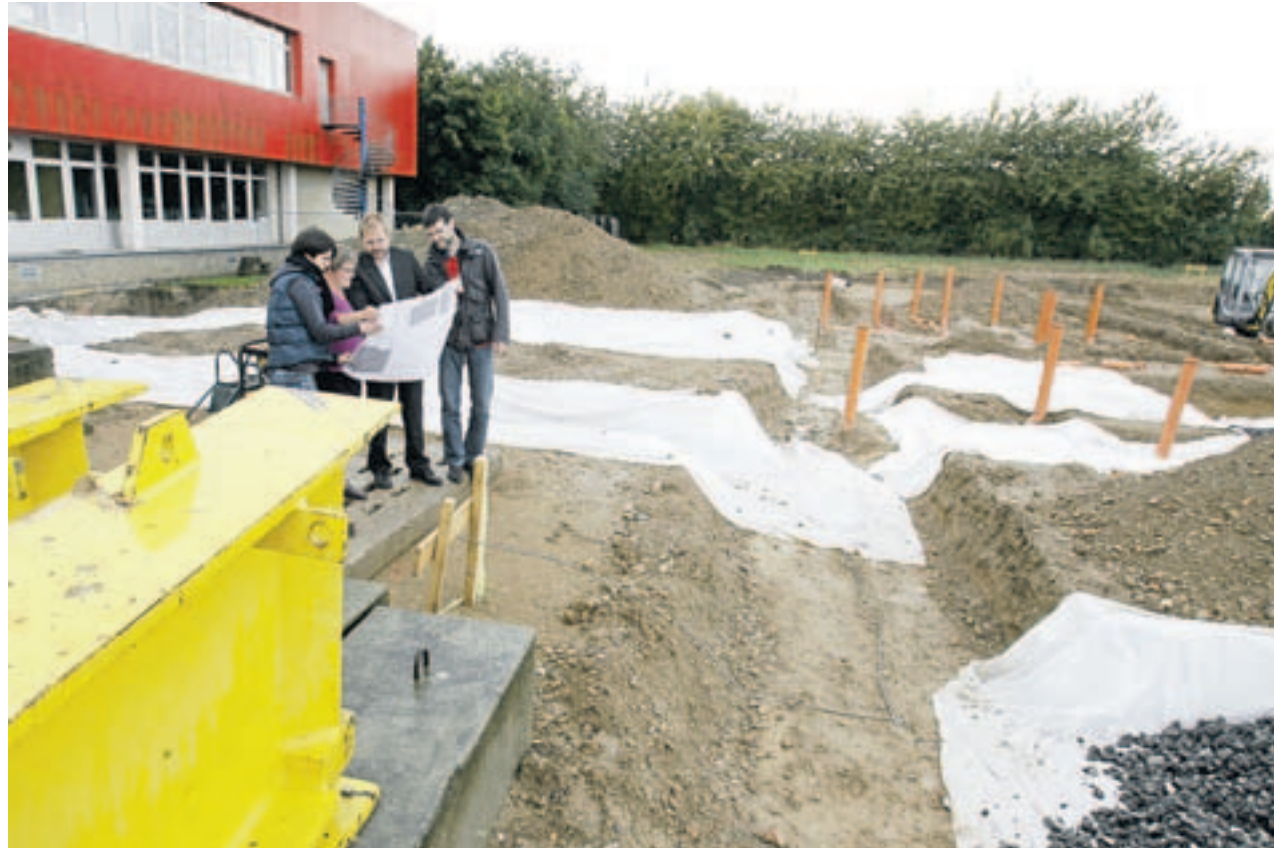
Auf der jungen Baustelle für den Neubau hinter dem (roten) Altbau (von links): die Lehrer Anne-Friederike Freißler, Ulrike Siebers, Schulleiter Jan-Peter Braun, stellvertretender Schulleiter Hans Knobel. Foto: Henrik Bode
